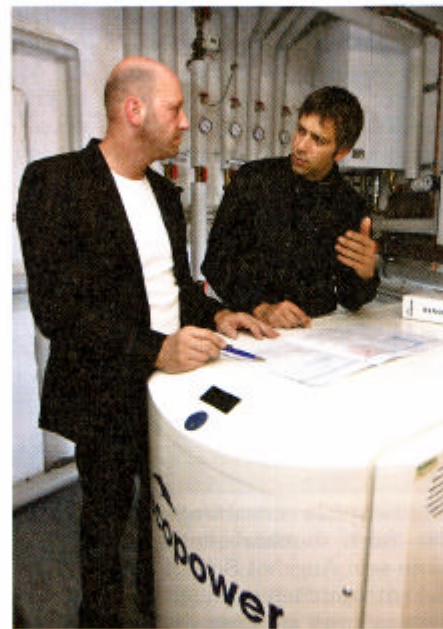
Heizungsfachmann Andreas Grünkorn (links) erläutert Frank Neumaier die Vorzüge der patentierten Leistungsmodulation des Mini-BHKW . Foto: egs
