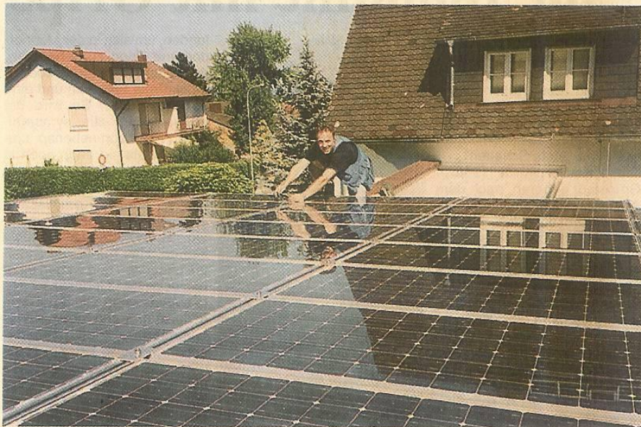
Elektromeister Markus Grünkorn beim Installieren einer Photovoltaik-Anlage. 14.3.2002
